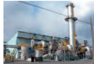
※コジェネ（コージェネレーション）とは、熱と電気を同時に供給することができる熱電併給のことで、ガスエンジン、ガスタービン、ディーゼルエンジンなどの原動機を使って発電を行いながら、同時に発生する排熱を給湯、暖房、冷房などに利用するシステムです。
