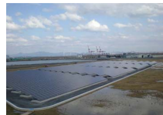
響灘太陽光発電所
