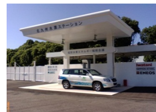
水素ステーション
