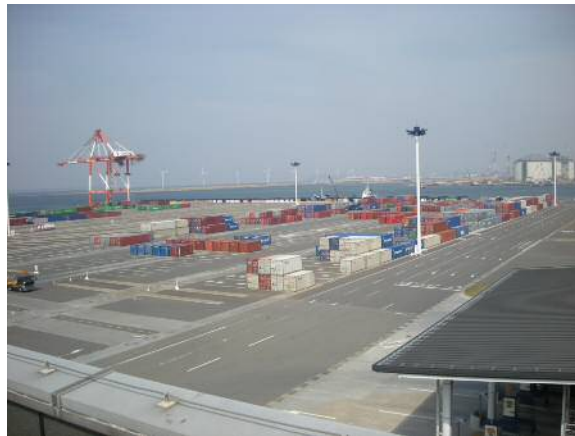
12・ひびきコンテナターミナル
