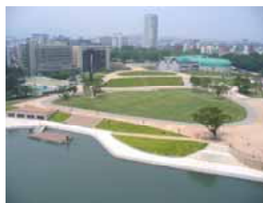
紫川と一体となった勝山公園
