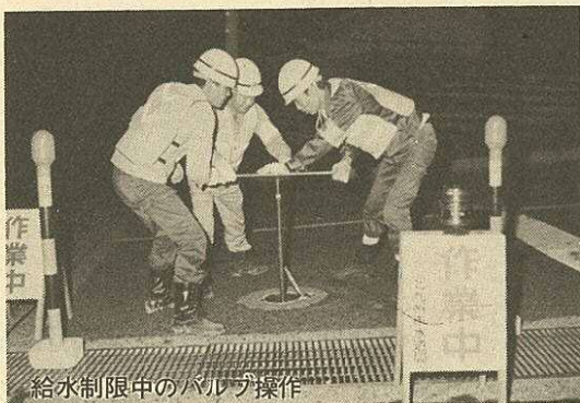
給水制限中のバルブ操作
