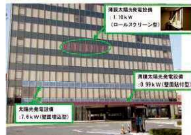
市役所本庁舎太陽光発電設備
