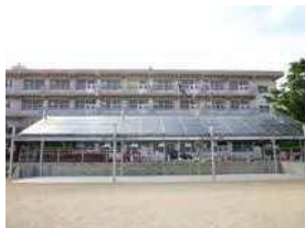
太陽光発電設備 (出力10kWの設置例)
