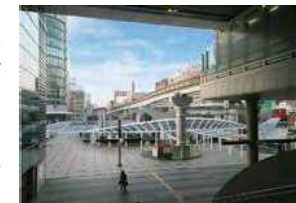
小倉駅ベストリアンデッキ
