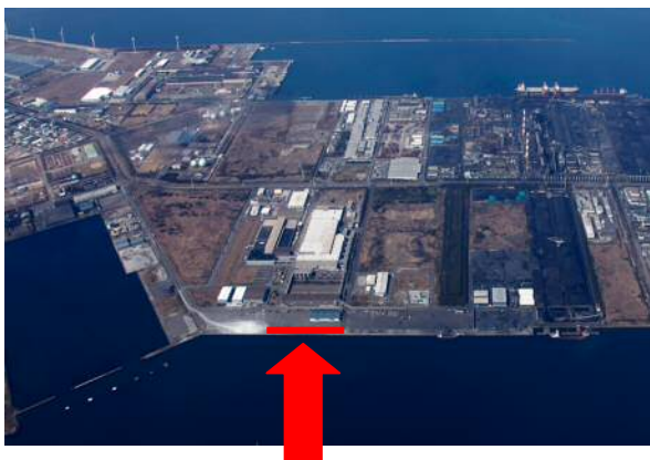
響灘南1号岸壁
