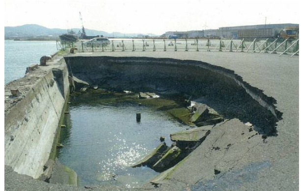
陥没したエプロン
