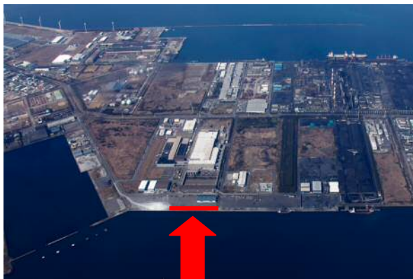
響灘南1号岸壁
