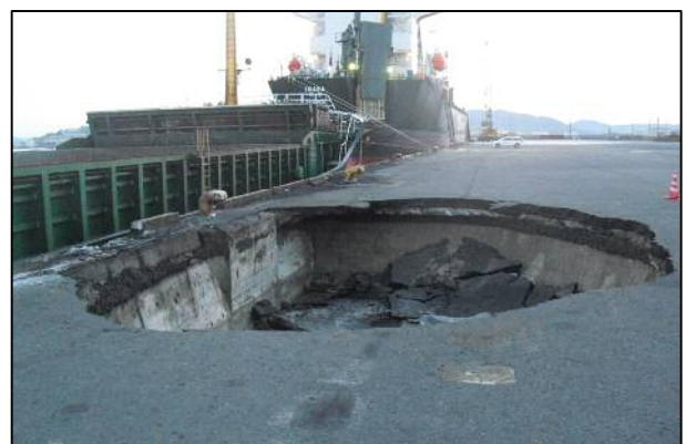
陥没したエプロン
