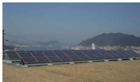
笹尾配水池太陽光発電（門司区）
