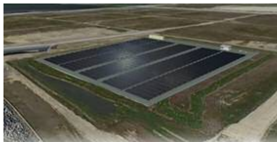
市民太陽光発電所（メガソーラー）【若松区響町】
