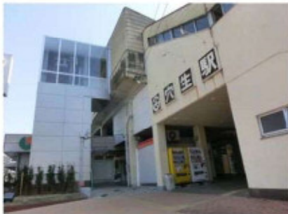
■エレベーターの設置（筑鉄穴生駅）
