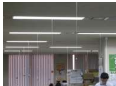
市役所本庁舎の引き紐スイッチ
