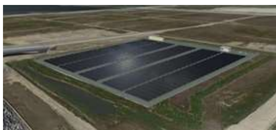
市民太陽光発電所（メガソーラー）【若松区響町】
