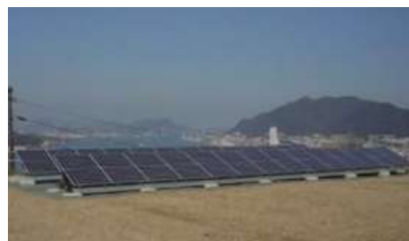
笹尾配水池太陽光発電 (門司区)
