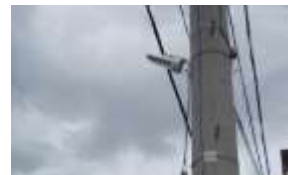
LED化された防犯灯
