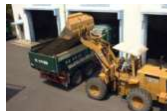
搬出される浄水汚泥
