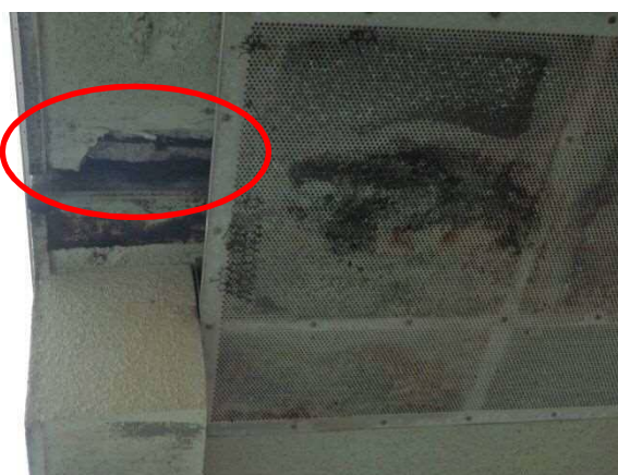
写真3 継ぎ目の劣化
