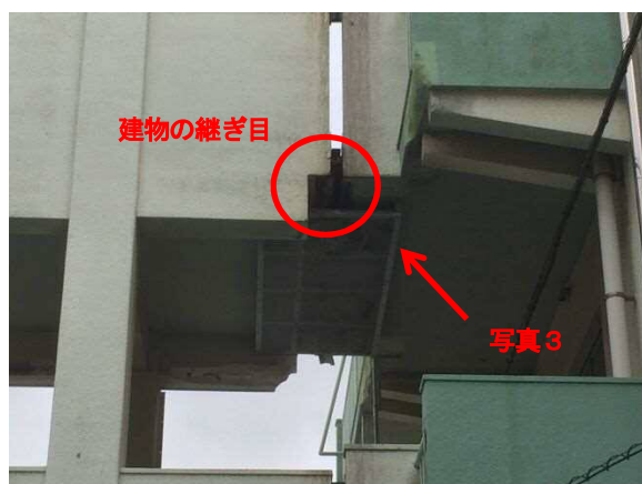
写真2 建物の継ぎ目
