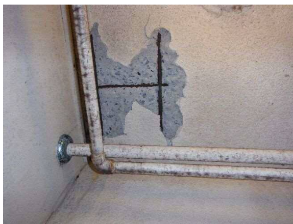
写真1 コンクリートが落下した後の天井
