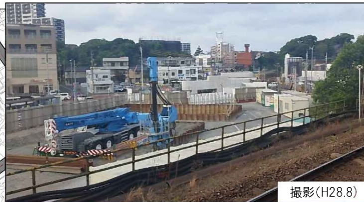
⑤ 筑豊本線高架工事（駅北）
