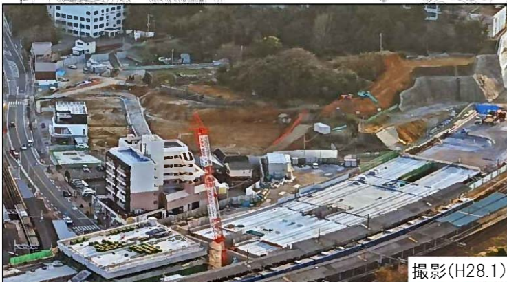
⑦ 宅地造成工事（堀川町地区）
