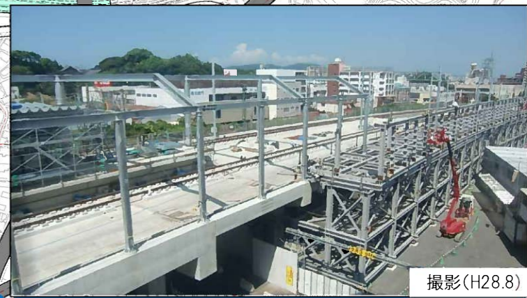
② 駅周辺鉄道高架工事（北鷹見町）
