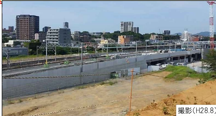
④ 駅周辺鉄道高架工事（堀川町）
