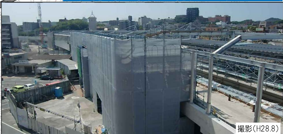
③ 駅周辺鉄道高架工事（駅東口）
