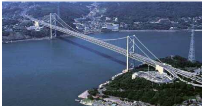
○関門橋の通行止め状況 (H22～H26)
