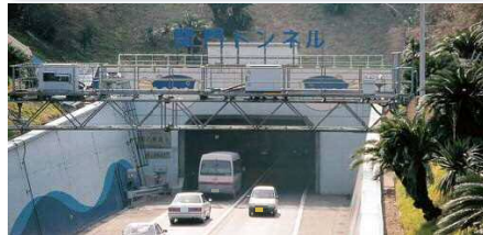
○関門トンネルのリフレッシュ工事による全面通行止めの状況(10年毎に実施)
