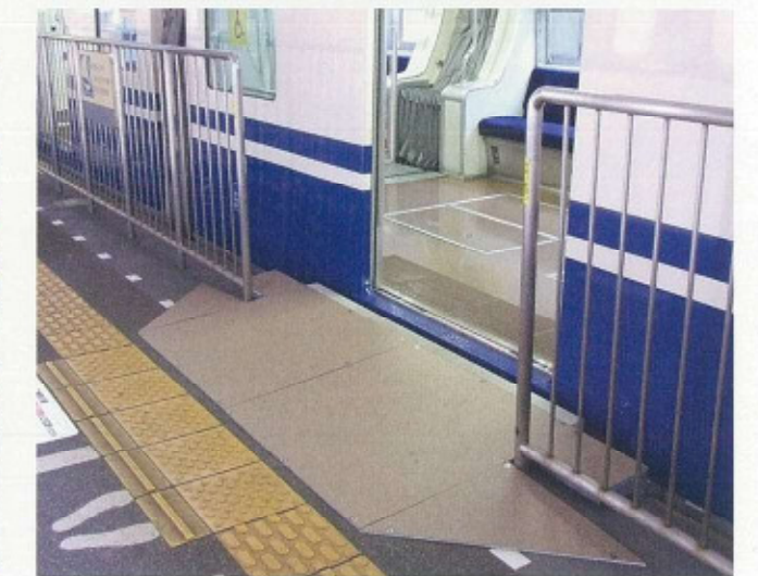
段差解消スロープ(全ホーム)
