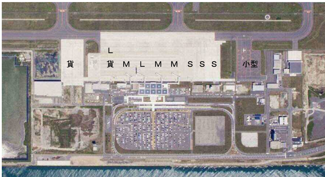
空港基本施設
