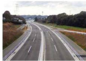
(都)竹並芦屋線 (国道495号竹並バイパス)
