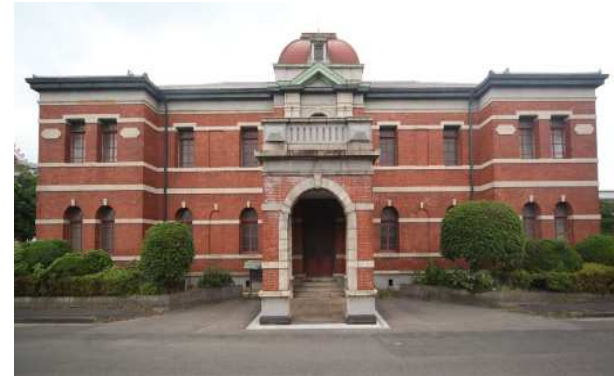
官営八幡製鉄所 旧本事務所
