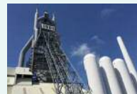
東田第一高炉
