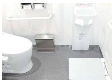
ベビーチェア、フィッティングボードが設置されたトイレ
