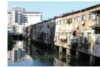
河川上空に張り出した店舗
