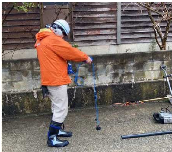
④漏水調査の状況 漏水音を確認する専用機器(漏水探知機)で 道路上から漏水調査(漏水箇所の特定)
