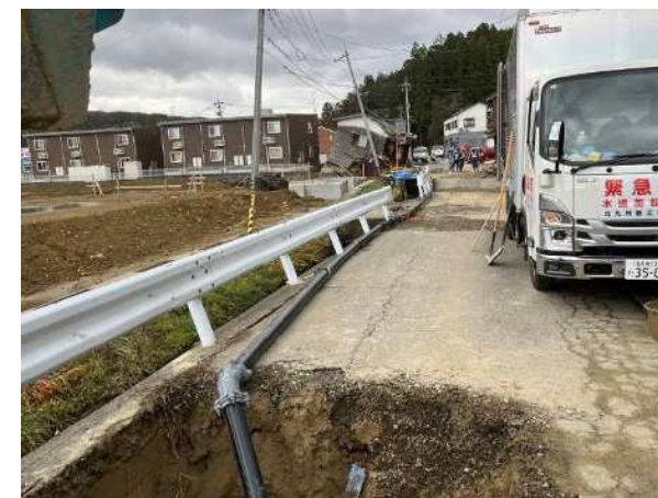
修繕状況(仮管設置) 水路下等で漏水修理に時間を要する場合は、早急に水を通すため、道路に仮管を設置(本復旧後は撤去)
