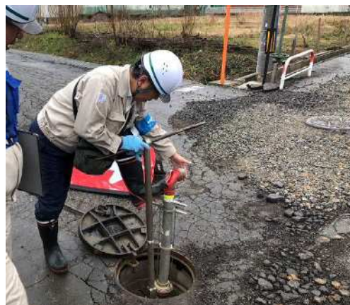
②水が出ない水道管の充水 バルブを操作することで管内に充水 ※漏水箇所の調査が可能
