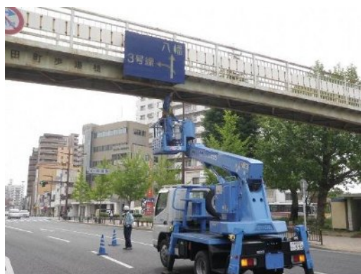
(a)高所作業車による点検状況
