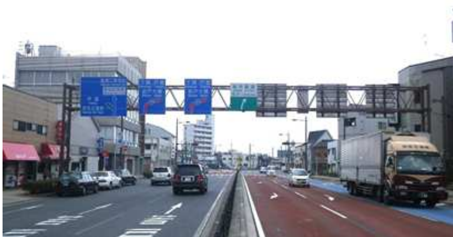
写真-1 市内の門型標識（例）
