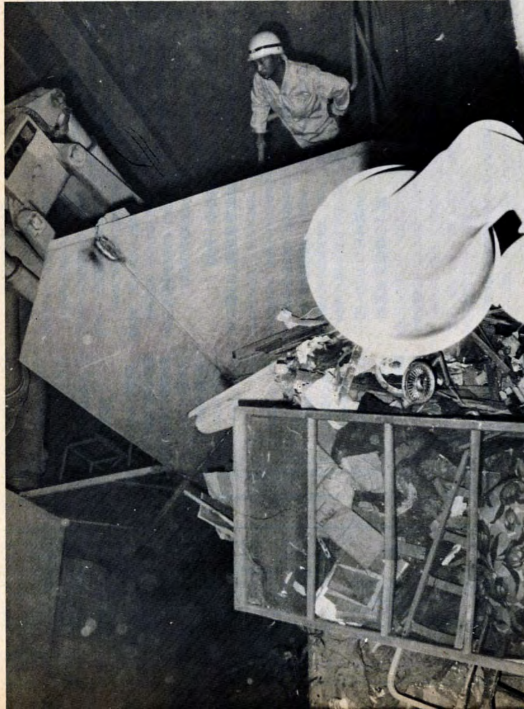
△破碎機に送りこまれたゴミは圧縮されながら巨大なハンマーやカッターで一瞬のうちに破碎される
