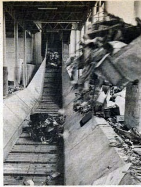
▷搬入されたゴミは計量後この供給コンベアで破碎機へ送りこまれる
