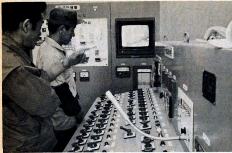
△機械は操作室で遠隔操作し破碎状況はテレビで監視できる
