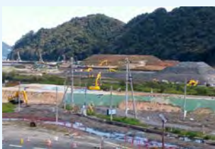
復興工事の様子(釜石市)
