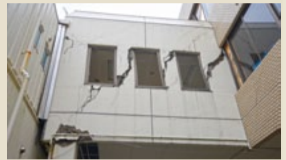
▲柱の損傷やひび割れのため使用できなくなった益城町役場の渡り廊下。5月に仮庁舎へ移転し、解体後に建て替えられる
