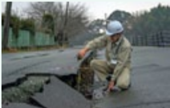
▲地震で道路に発生した大きな段差を計測する相浦さん
