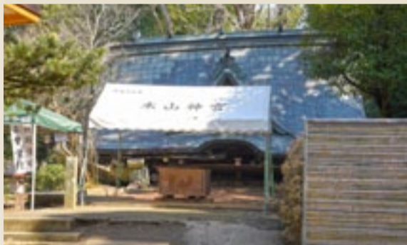
▲社殿が押しつぶされた木山神宮。復興への祈りに人々が訪れる場所となっている
