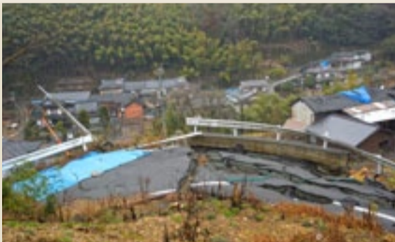
▲甚大な被害を受けた地区では、いまだに通行できない生活道路も多い
