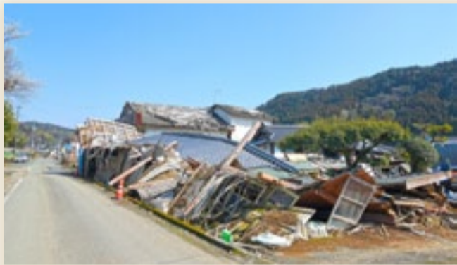
▲郊外では崩壊した多くの家屋が手付かずの状態が残っている
