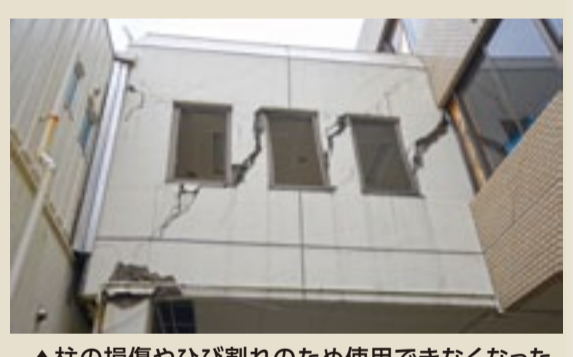
▲柱の損傷やひび割れのため使用できなくなった益城町役場の渡り廊下。5月に仮庁舎へ移転し、解体後に建て替えられる
