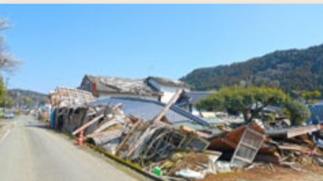
▲郊外では崩壊した多くの家屋が手付かずの状態が残っている
