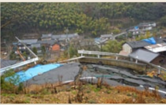
▲甚大な被害を受けた地区では、いまだに通行できない生活道路も多い
