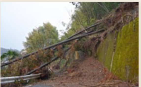
▲山間部では、地震や昨年夏の大雨による土砂崩れのため、現在も通行できない道路が多数ある
