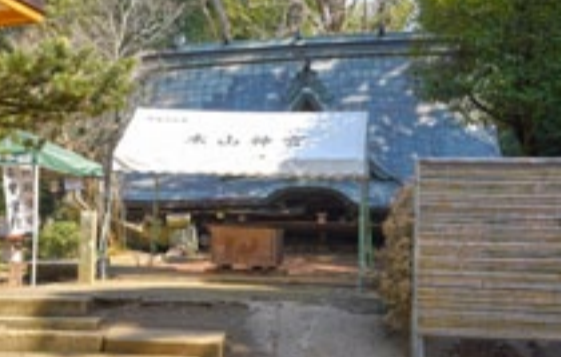
▲社殿が押しつぶされた木山神宮。復興への祈りに人々が訪れる場所となっている
