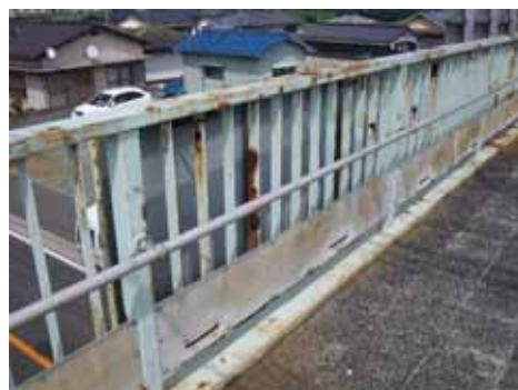
～ 歩道橋の補修・塗装 ～
