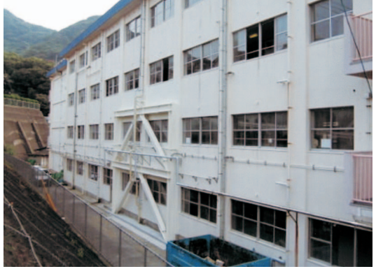
耐震化された桜丘小学校
