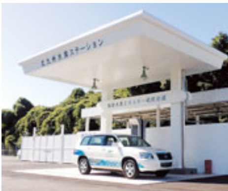
北九州水素ステーション
