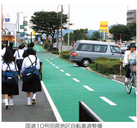
国道10号田原地区自転車道整備
