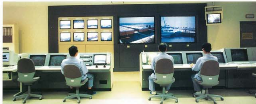
中央監視制御室
