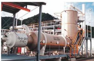
不燃性ガス供給設備
