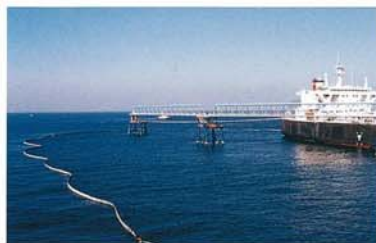
シーバースの浮沈式オイルフェンス
