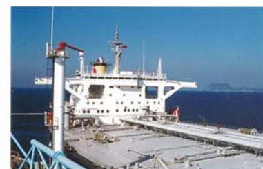
固定泡放射砲(シーバース)
