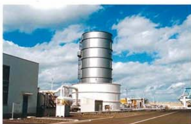
原油ガス処理設備*
