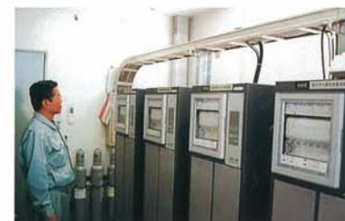
水質・大気監視設備
