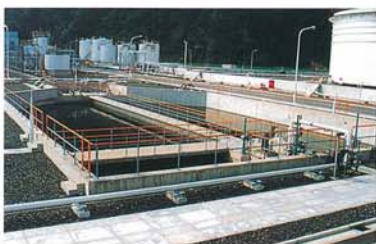
排水処理設備：ガードベイスン
