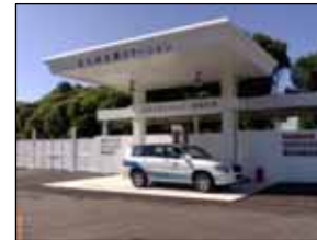
水素ステーション
