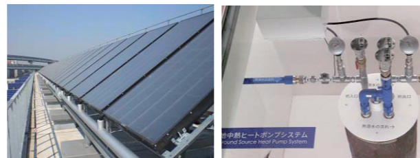
寮に設置した太陽熱パネル(左)とスマートヒートポンプシステム(右)(寮)
