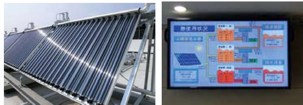
病院に設置した太陽熱パネル(左)と見える化モニター(右)(病院)
