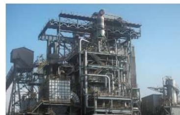
コークスを製造するときに発生する熱を使って蒸気をつくり発電しています。蒸気は発電のほか近隣の工場へも供給しています。
