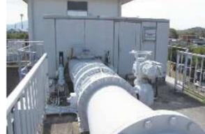
ダムや川など、水が高いところから低いところへ落ちる力を利用して、化石燃料を使わない水力発電をしています。この地域では、貯水池から浄水場へ流れる水の力を利用して発電します。
