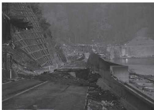
釜石市両石町（防潮堤）
