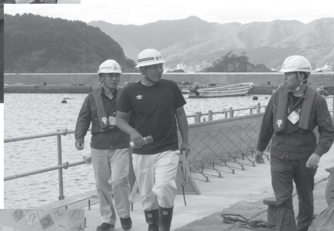
漁港整備の現場
