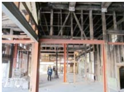
④-3 鋼材による複数の補強の跡
