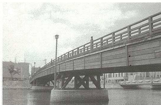
常盤橋（木の橋）
