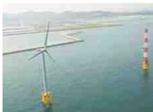
洋上風力発電実証研究
