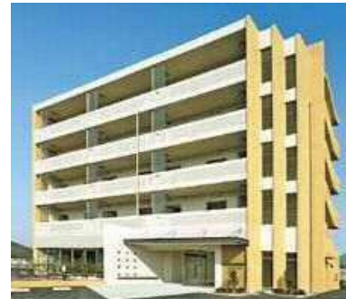
竣工 平成19年2月
