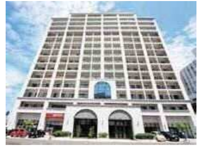
竣工 平成25年2月
