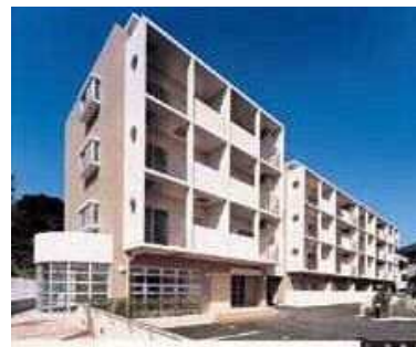
竣工 平成14年3月
