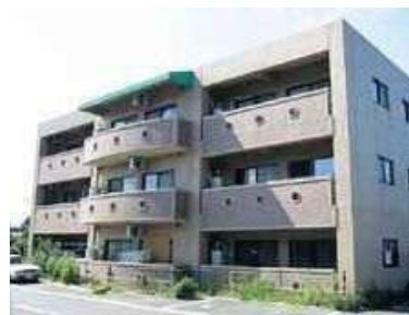
竣工 平成14年1月
