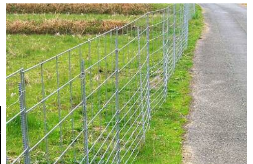
図2 【ワイヤーメッシュ設置状況】
