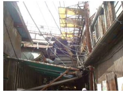
建物等の老朽化
