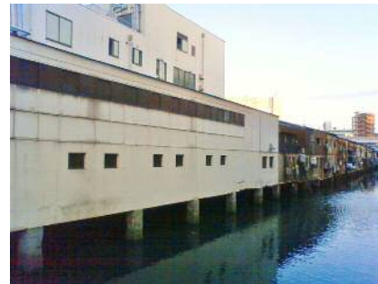
神嶽川に張り出した建築物
