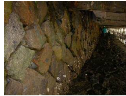
老朽化した護岸
