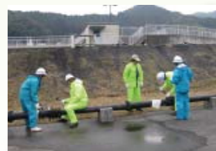
▲管路修繕研修
