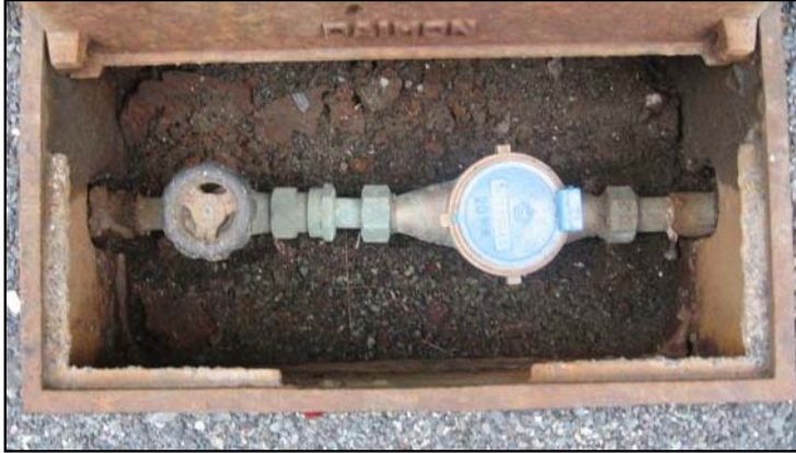
水道メーター保温前
