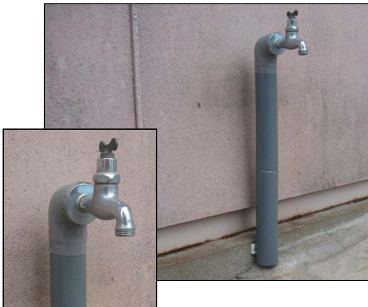
保温チューブ取付後 (蛇口付近取付)
