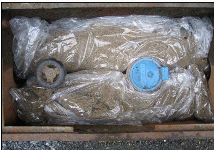
水道メーター保温後
