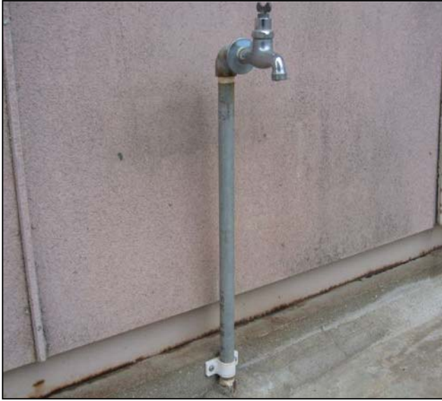
保温チューブ取付前
