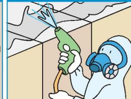
吹付けアスベスト等の層を残したまま、薬剤等の含浸や造膜材の散布により、吹付けアスベスト等を固定することで飛散を防止する工法。除去工法より安価ですが、建物の解体時などには、除去工事が必要になります。
