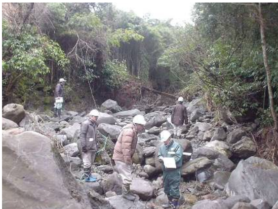
【現地調査状況】
