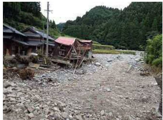
被災当時のうきは市・鹿狩川
