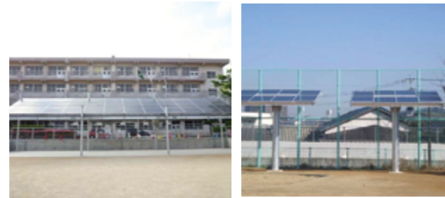
太陽光発電設備(出力10kWの設置例) 太陽光発電設備(出力3kWの設置例)
