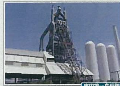
東田第一高炉跡
